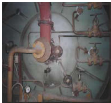
Рис.1. Схема (а) и вид на торцевую часть (б) топочной камеры восстановительного реактора линии получения серы УПЭС МЗ ЗФ «НН». 1 – форкамера, 2 – реактор, 3 – запальная горелка, 4 – сопло ввода сернистого газа, 5 – сопла подачи топлива, 6 – коллектор восстановителя, 7 – сопла для подачи восстановителя, 8 – турбулизующая решётка.
