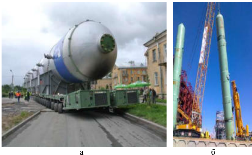
Рис.1. Реакторы, изготавливаемые на Ижорском заводе: транспорт реактора объемом 300 м 3 на Туапсинский НПЗ (а) и монтаж двух реакторов объемом по 200 м 3 на Ангарском НПЗ (б)
