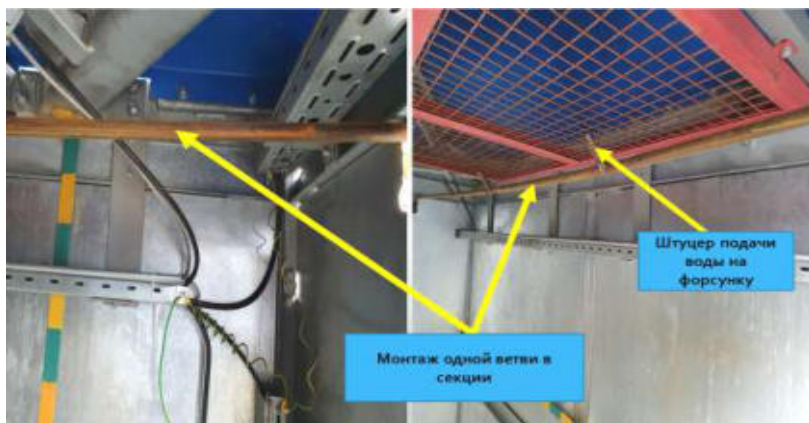
Рис. 2. Монтаж одной ветви подачи воды внутри секции
