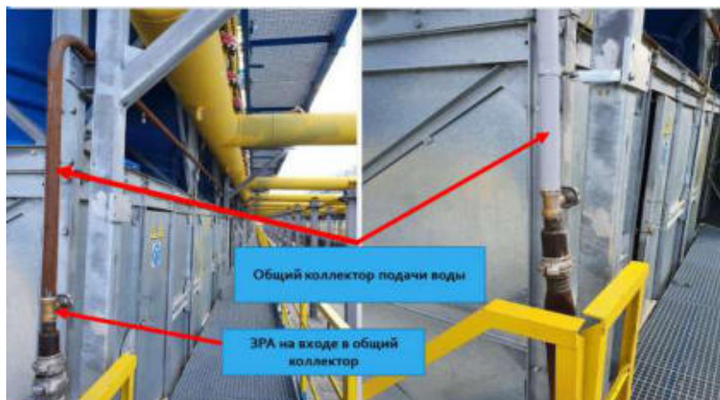
Рис. 3. Монтаж общего коллектора воды
