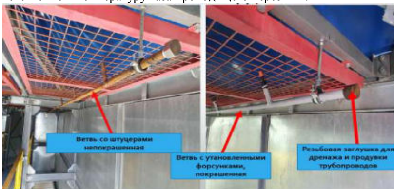
Рис. 5. Расположение ветвей подачи воды
