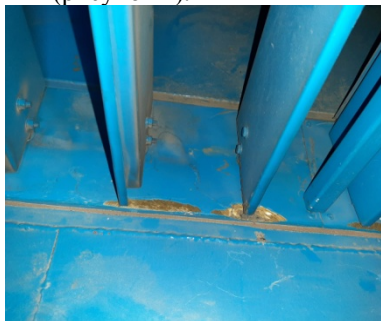
Рисунок 1 Конструкция ламелей до модернизации
